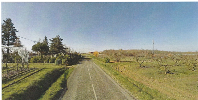
Photo montage du dossier de demande de travaux ; l'antenne est à droite de la photo.
